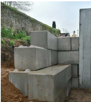
Mur de soutènement
