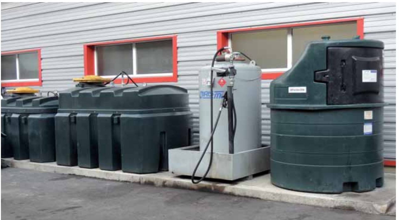
En bas : station de stockage des fluides, avec système de rétention
