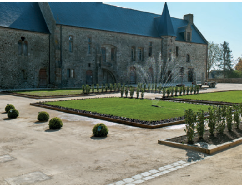
Réalisation de travaux paysagers au Prieuré d'Ardevon.
